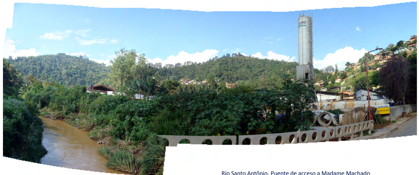
Río Santo Antônio. Puente de acceso a Madame Machado
