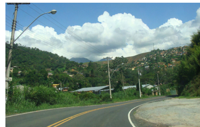
Carretera BR-495 (Petrópolis-Teresópolis), junto a Madame Machado
