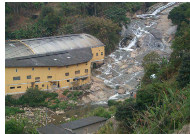
Distrito II, Cascatinha. Área industrial y cuenca de escorrentía
